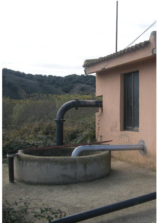
**Figura 49. Captación de agua para riego**
