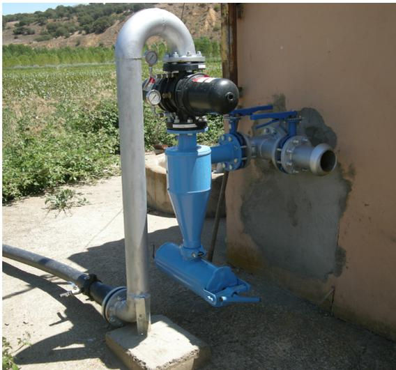
**Figura 58. Filtro en el sistema de riego por goteo**
